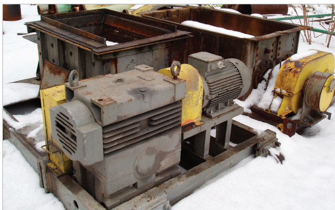
Obr. 3: Původní drtič strusky 15 t.h -1 po demontáži.
