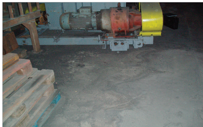
Obr. 6: Drtič strusky 40 t.h -1 při opravě.
