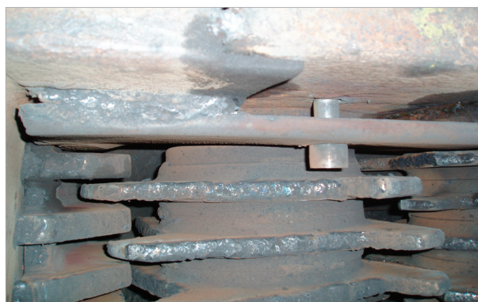
Obr. 8: Detail opotřebených drticích válců.
