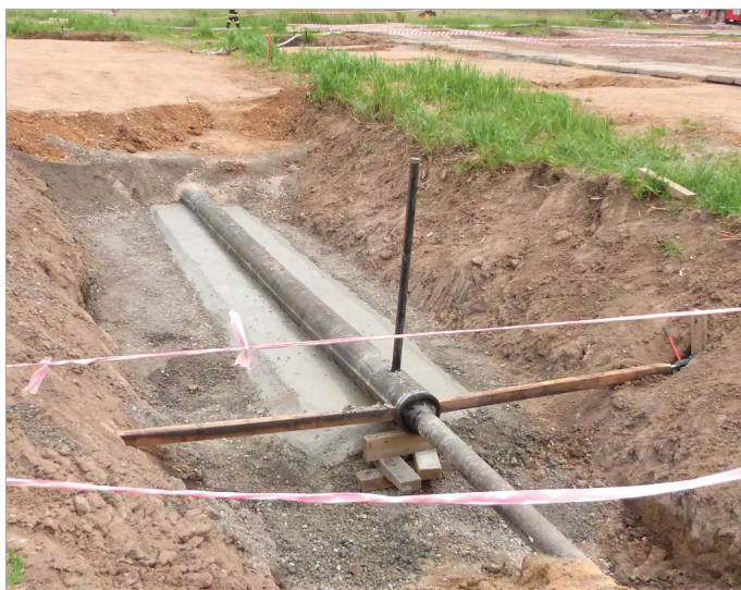
Obr. 2: Realizace chrániček na potrubí.
