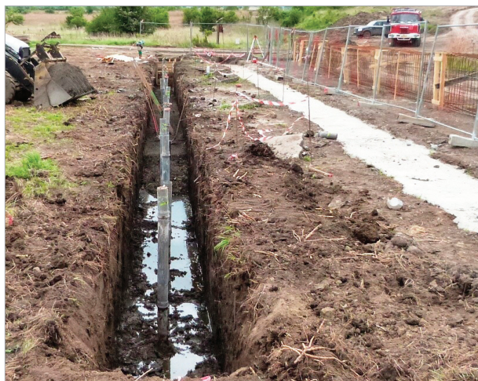
Obr. 3: Realizace přemostění plynovodu za pomoci mikropilot a ŽB pasů.
