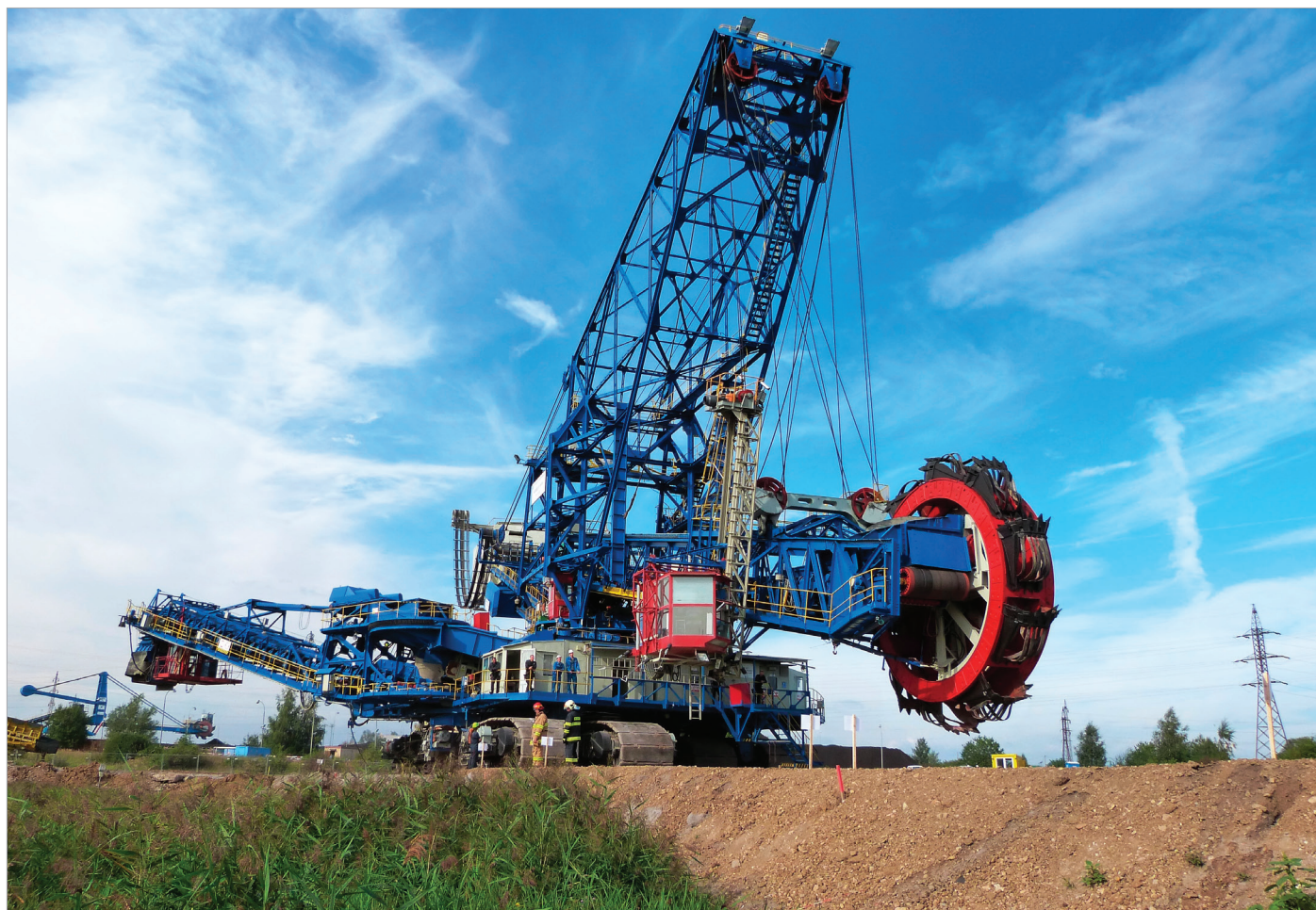
Obr. 6: Transport rypadla přes podzemní síť Hořanského koridoru.
