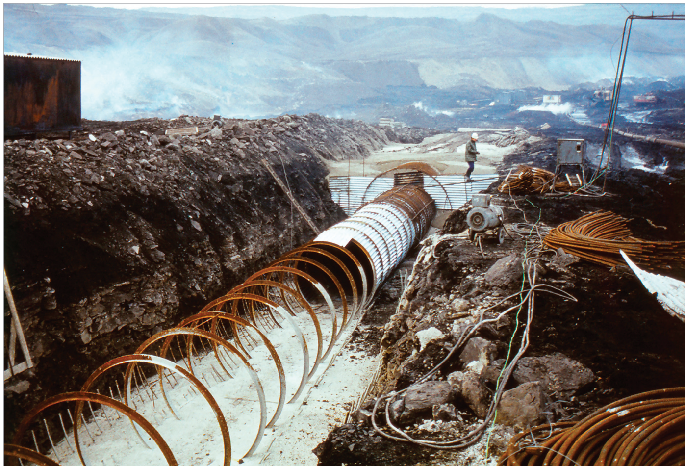
Obr. 8: Stavba průleznové štolý čerpací stanice na dně pánevní deprese ČSA.
