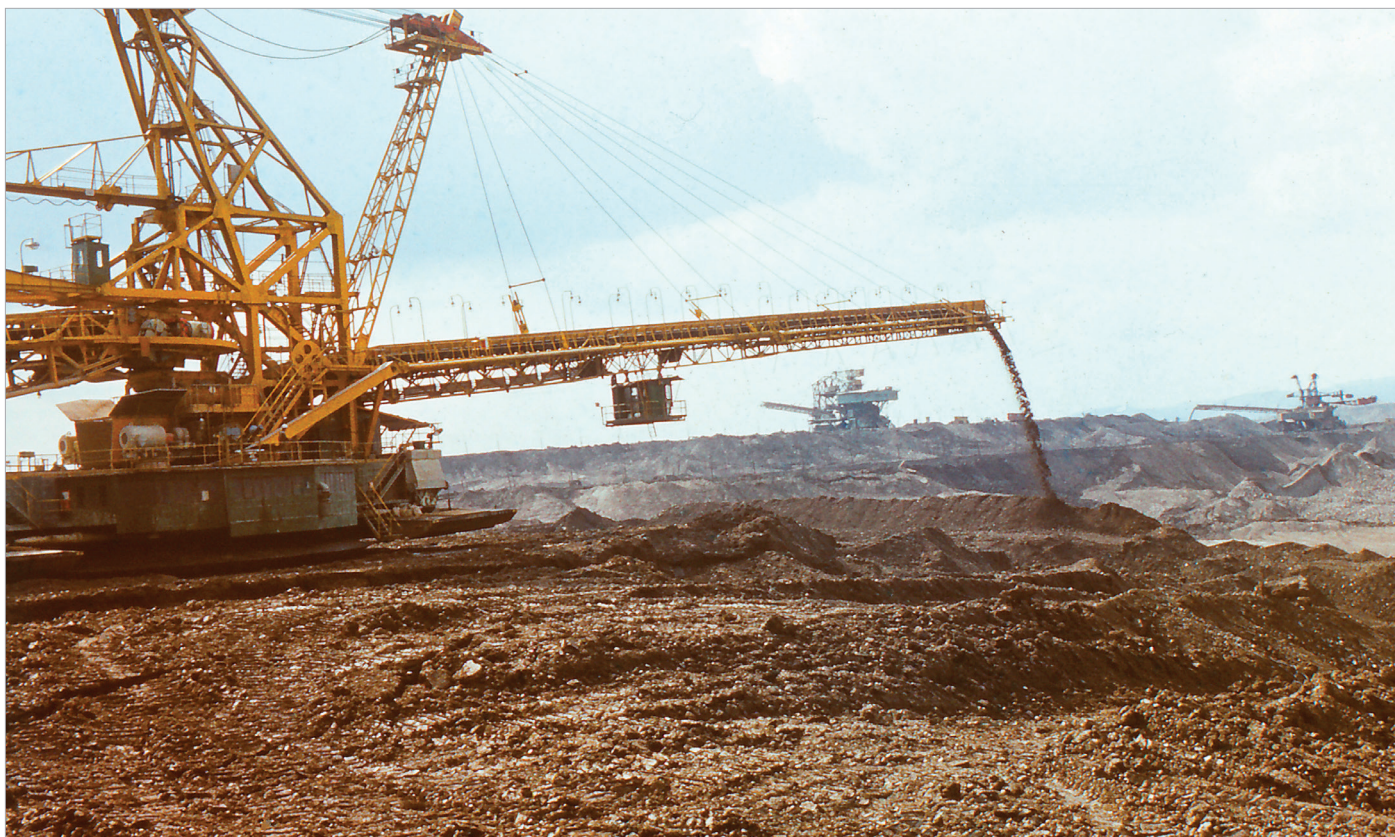
Obr. 15: Soustředěné zakládání koruny koridoru zakladači ZP 6600, Z 200/78 a ZD 1800/59.
