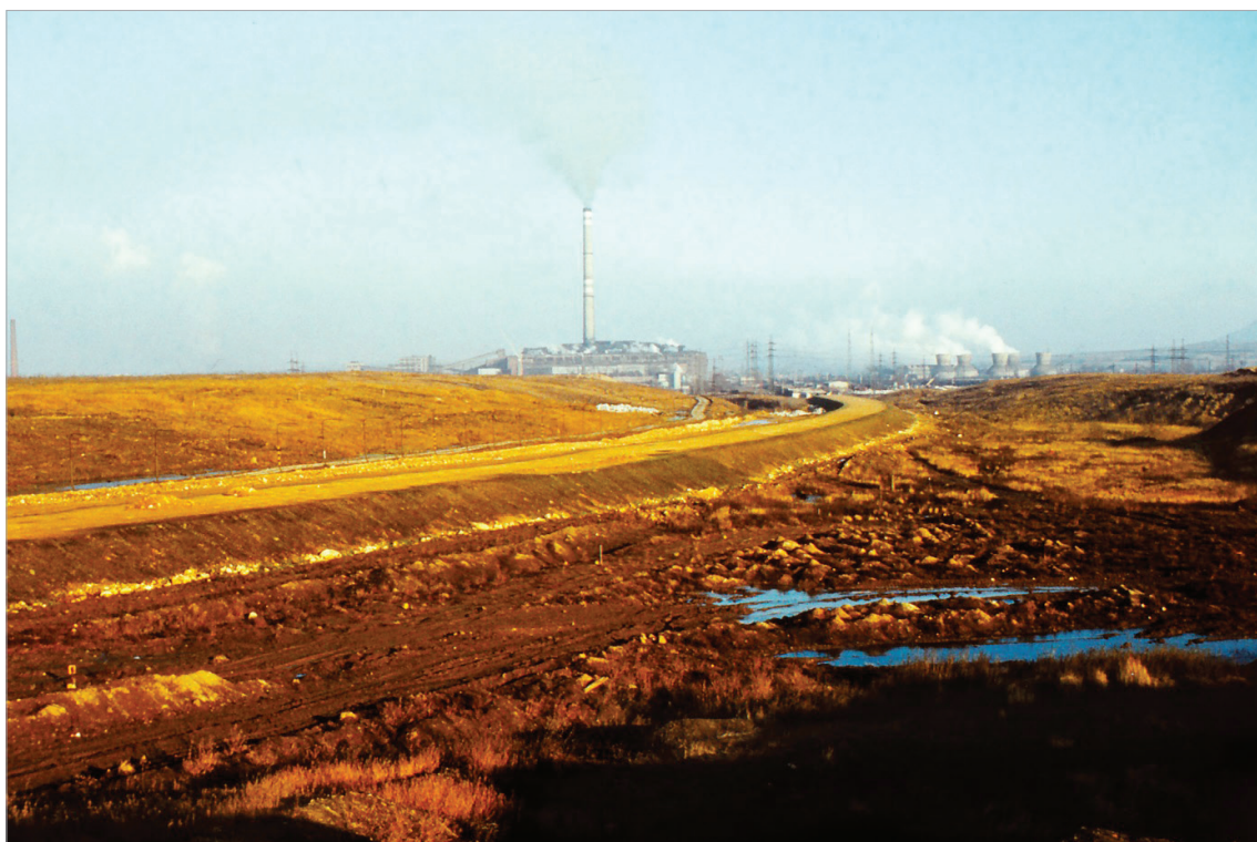
Obr. 10: Založené suťové těleso ČSD-východ.
