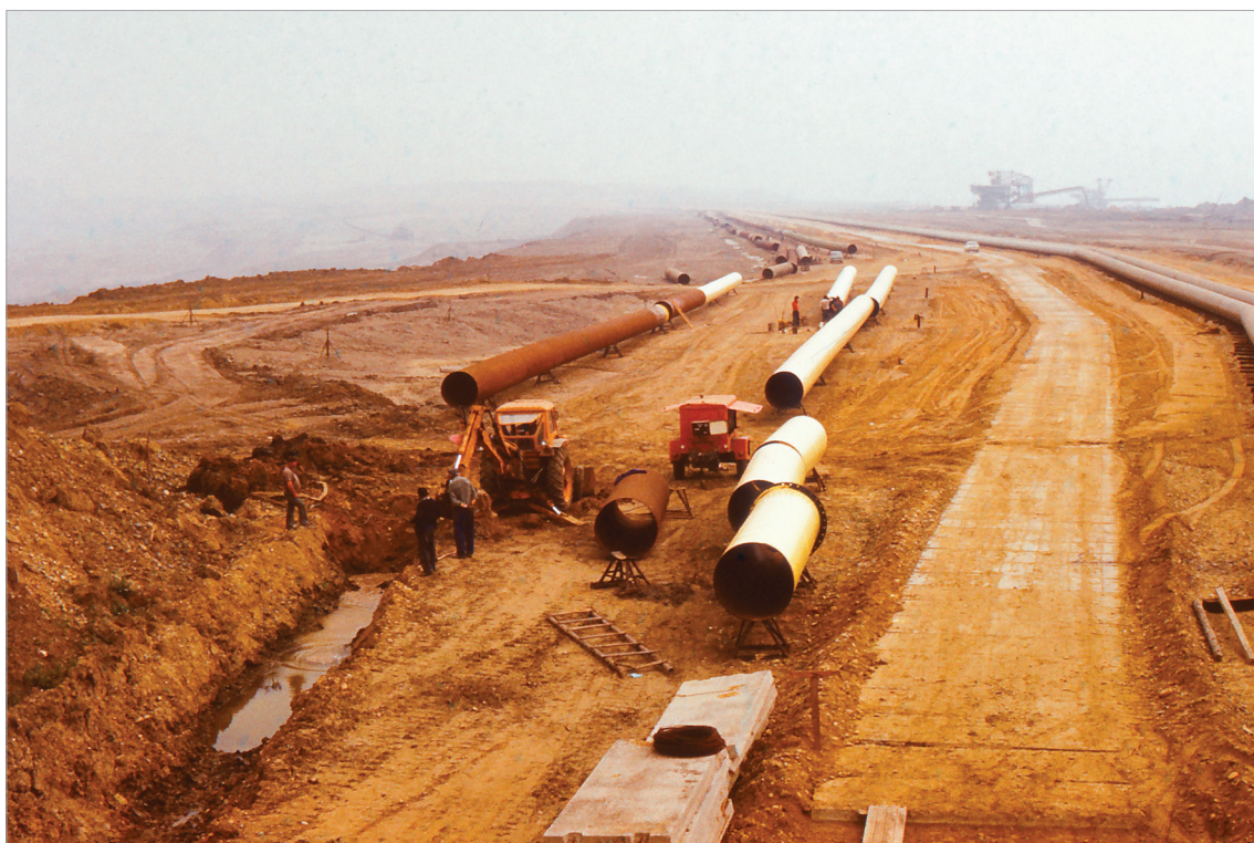
Obr. 14: Výstavba potrubní přeložky Bíliny.
