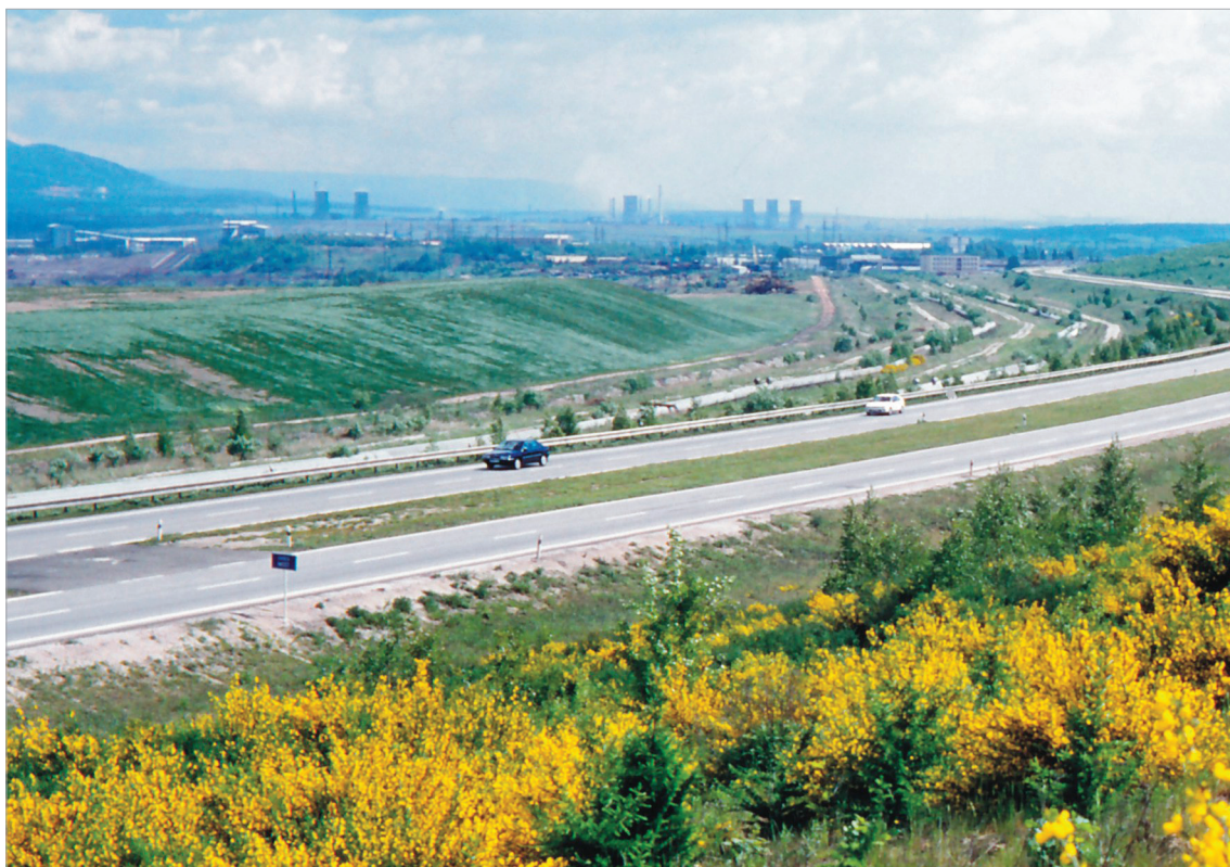
Obr. 16: Dokončená stavba silnice dálničního typu I/13.
