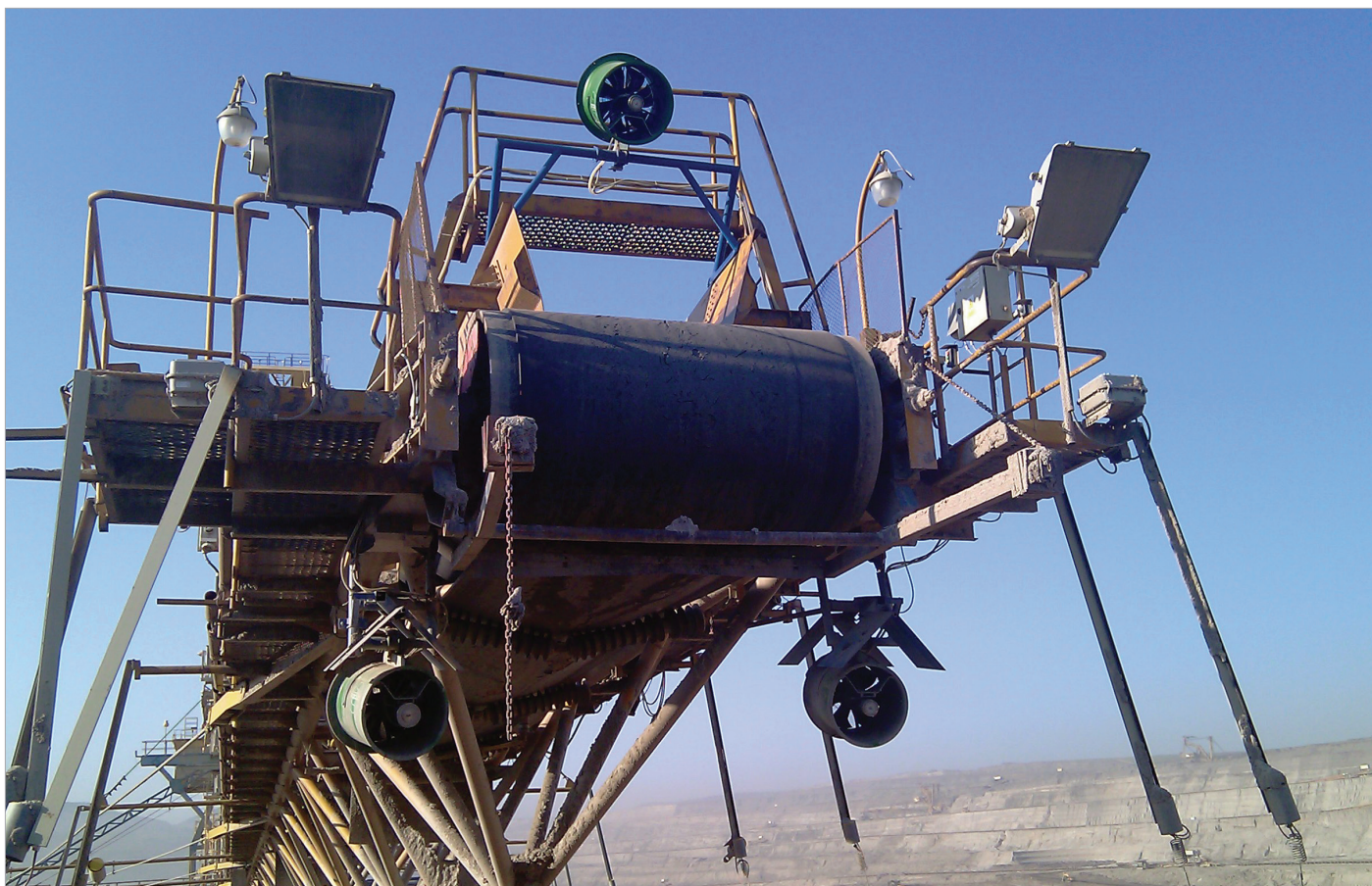
Obr. 2: Umístění mlžícího zařízení na špičce základacího výložníku ZPD 8000/98.
