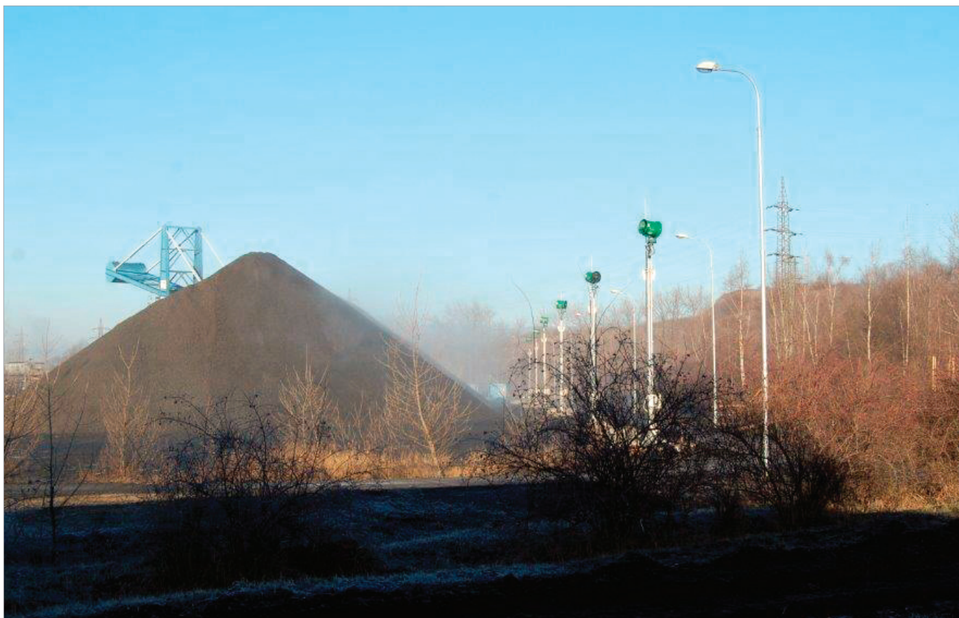
Obr. 3: Mlžící stěna na provozní depu č. 2 Vršanské uhelné a.s.
