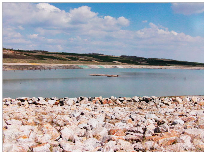
Obr. 5: Opevnění severního břehu jezera Medard. Foto: Fultner 04/2014.
