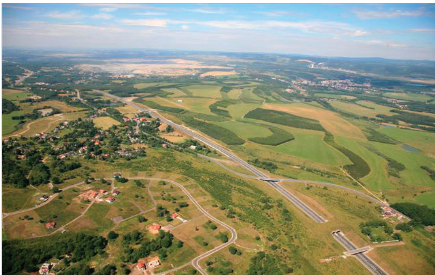
Obr. 3: Úprava krajiny na výsypce Velká Loketská (502,16 ha) formou všech způsobů rekultivace (zemědělská, lesnická, hydrická rekultivace).
