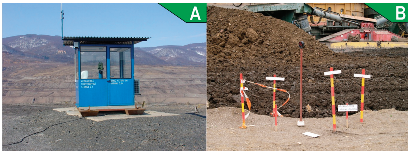
Obr. 2: Automatická totální stanice Leica TCA 2003 v klimatizované kóji na dně lomu ČSA (A). Tzv. operativní geodetický bod zasazený do plastového mezníku (B).
