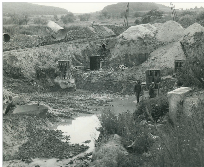
Obr. 7: Jímací objekt štolý se širokoprofilovými svodovými vrty. (Foto: St. Hurník, 1984).
