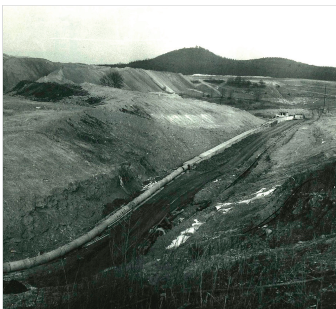
Obr. 9: Odvodňovací drén A1. (Foto: St. Hurník, 1985).
