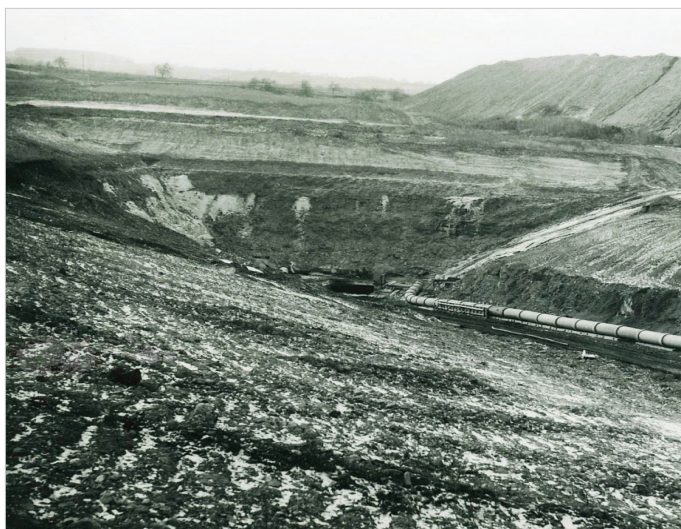
Obr. 8: Zaústění odvodňovacího drénu do jímacího objektu štoly. (Foto: St. Hurník, 1985).
