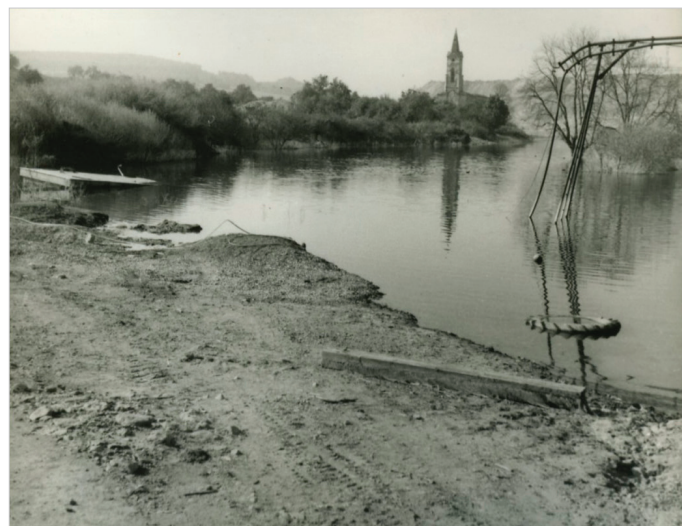
Obr. 3: Akumulace povrchových a srážkových vod před čelem výsypky. (Foto: St. Hurník, 1981).
