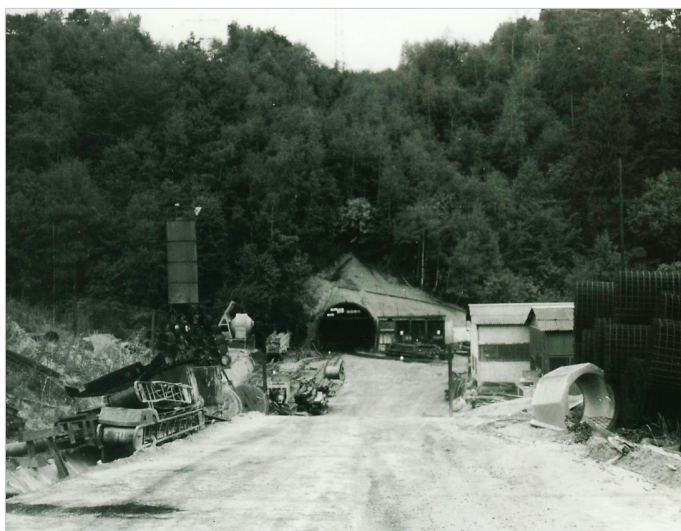
Obr. 6: Portál odvodňovací štolý Radovesice. (Foto: St. Hurník, 1987).
