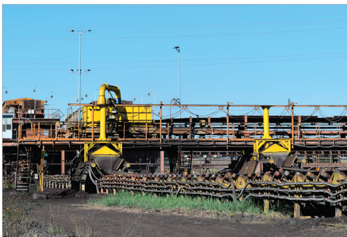
Obr. 9: Odprášení přesypu VH 163→PD 156, PD 146.
