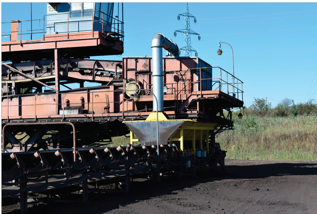
Obr. 11: Odprášení přesypu PD 160→PD 161.
