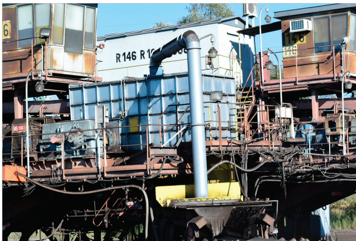
Obr. 6: Odprášení přesypu PD 156→PD 157.
