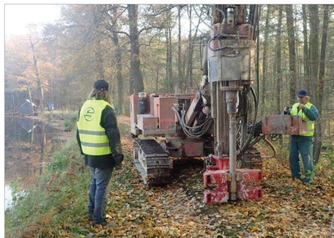
Obr. 3: Provádění vrtání vrtnou soupravou.
