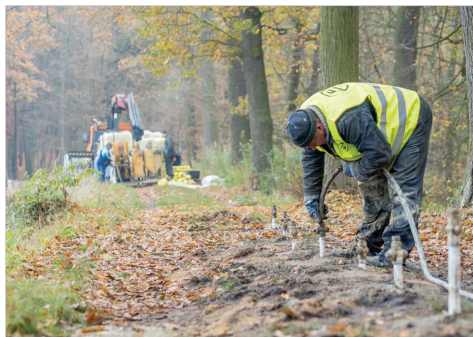
Obr. 5: Osazení jednoho z vrtů gumovou hadicí.
