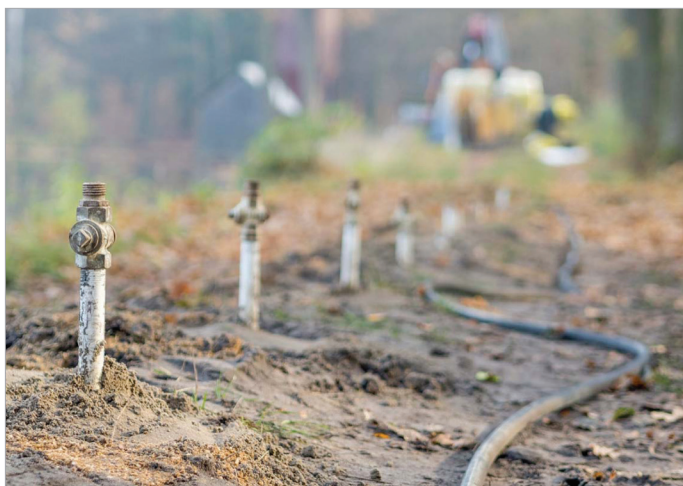
Obr. 4: Polymerní trubky s plnicími ventily.
