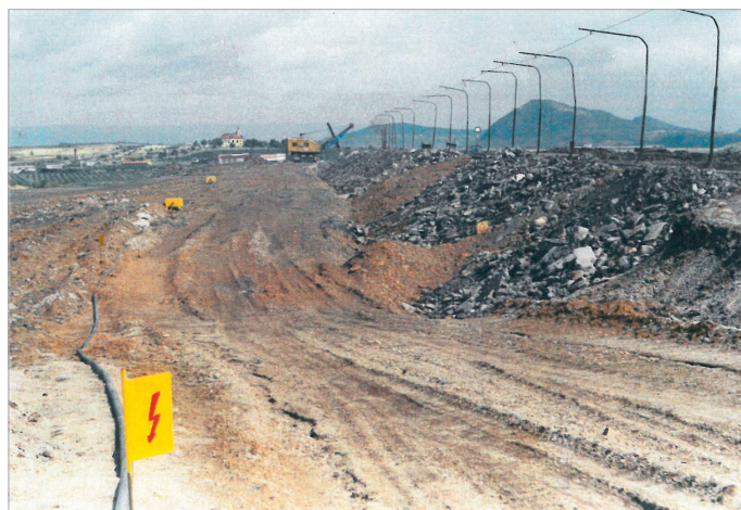
Obr. 4: Překrývání a utěšňování skládky TKO dvěma 0,5 m vrstvami těsnících jílu.
