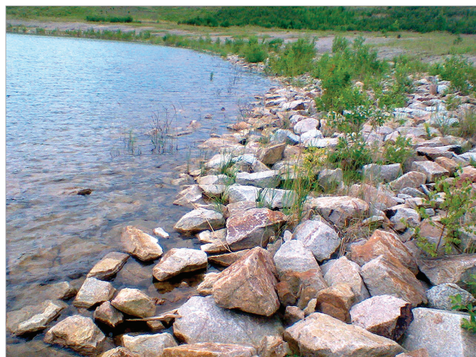
Obr. 4: Opevnění břehové linie v jihozápadní části jezera. (Foto: Valvoda, 05/2017)
