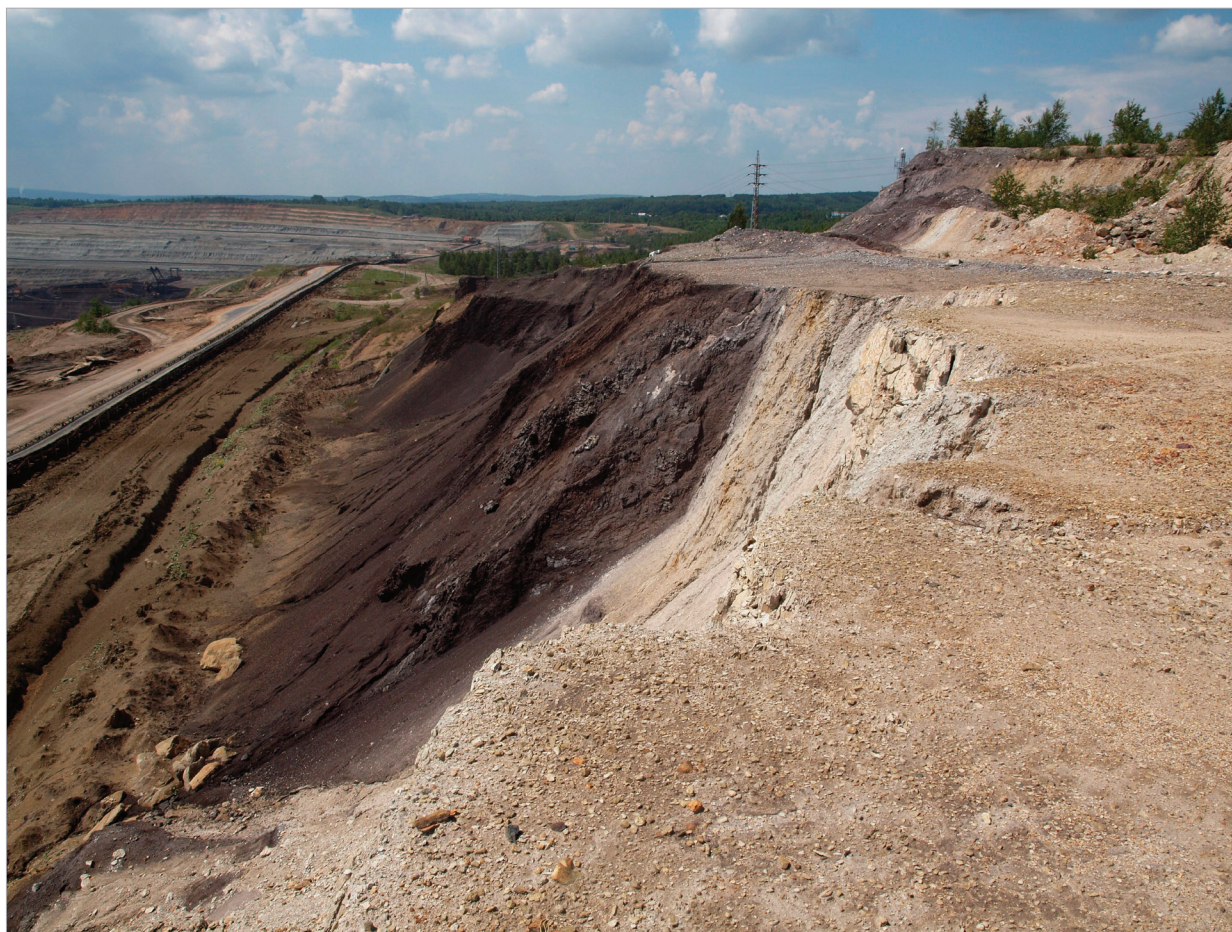
Obr. 3: Lipnický zlom s tvrdými žebry silicitů ve sloji Antonín, lom Jiří, výška stěny 21 m. Foto: P.
