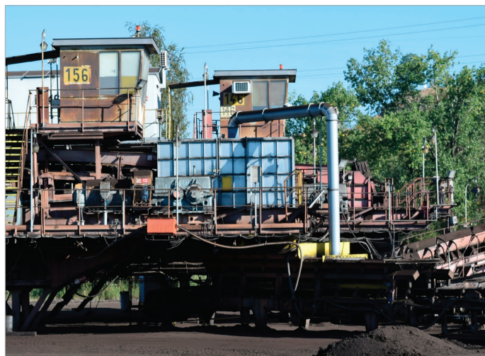
Obr. 3: Odprášení přesypu PD 156→PD 157
