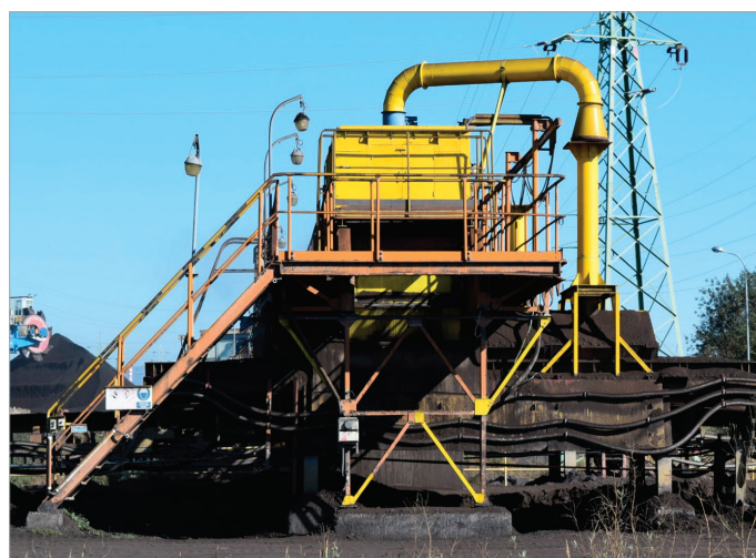
Obr. 4: Odprášení přesypu VH 163→PD 156, PD 146.
