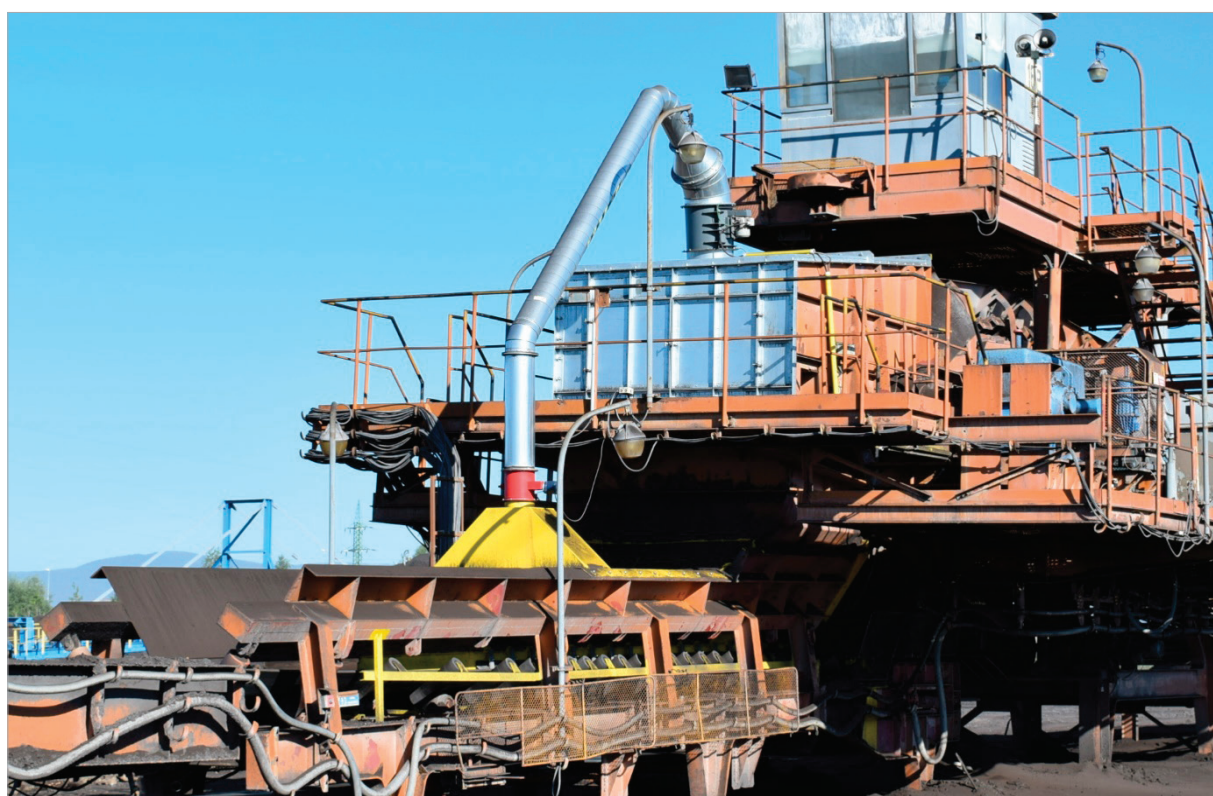
Obr. 7: Odprášení přesypu PD 162→PD 163.
