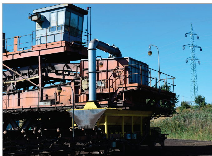
Obr. 6: Odprášení přesypu PD 160→PD 161.
