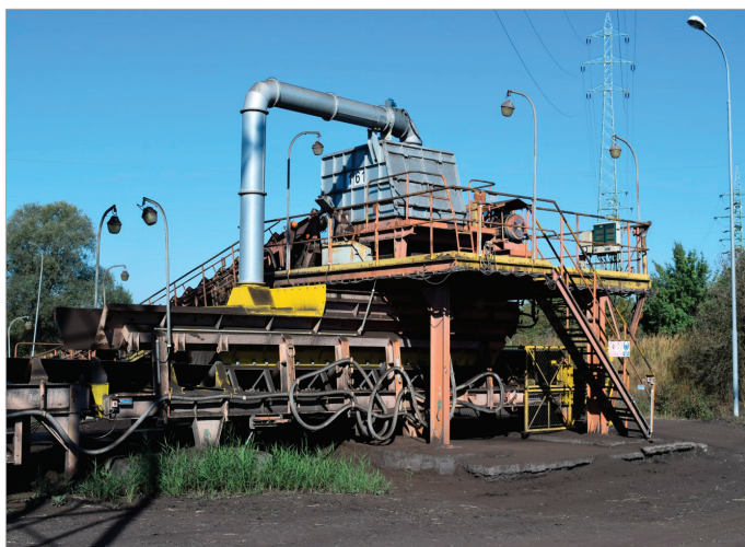
Obr. 5: Odprášení přesypu PD 161→PD 162.
