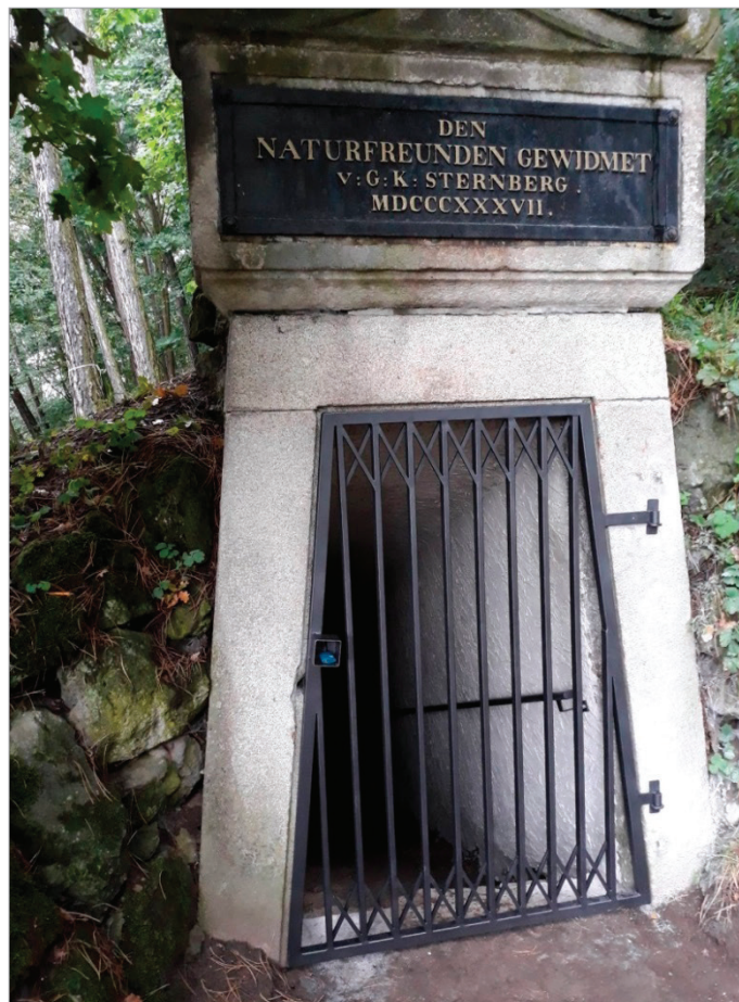
Obr. 14: Nově opravený vstupní portál do Goetheho štoly, který nechal v roce 1837 osadit hrabě K. M. Sternberg nápisem „Věnováno přátelům přírody“. Foto: M. Brož
