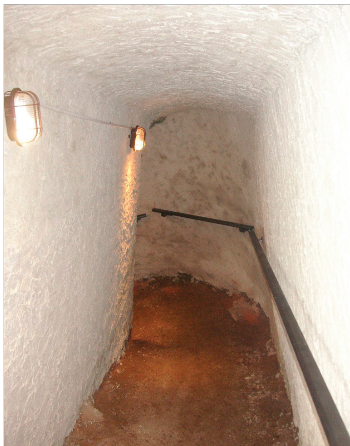
Obr. 16: Sanovaná vstupní chodba do podzemí Komorní hůrky (září 2017). Foto: M. Brož
