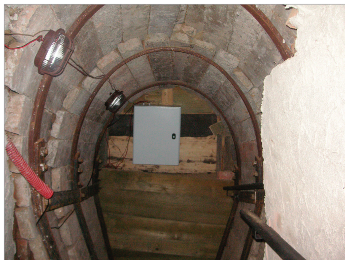
Obr. 17: První úsek podzemní chodby osazený pražskou výztuží. Foto: M. Brož
