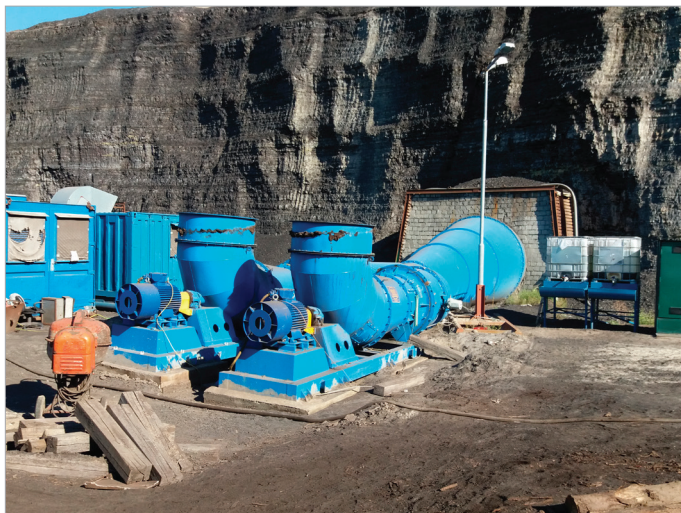
Obr. 3: Vyústění výdušného důlního díla č. 3112 na lomu
