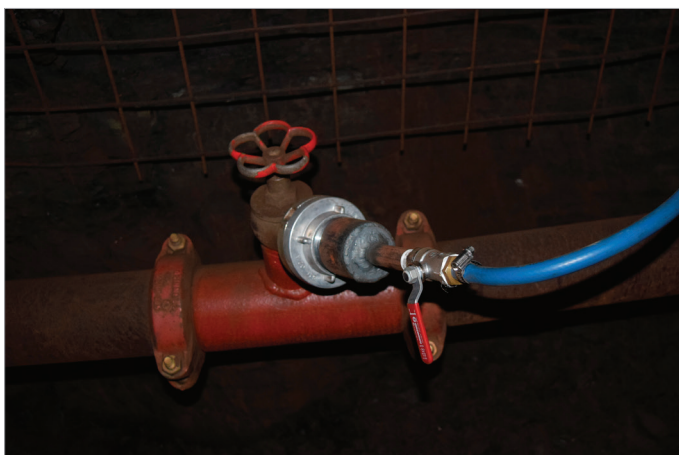
Obr. 6: Napojení přívodu vody.
