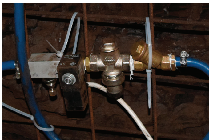
Obr. 7: Vodovodní regulační sestava.
