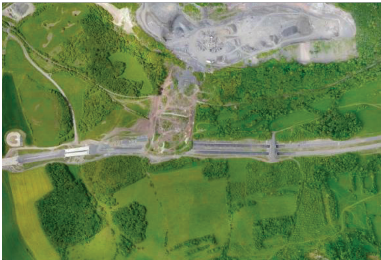
Obr. 9: Rozsáhlý skluz v oblasti dálnice D8 (rok 2013). [4]
