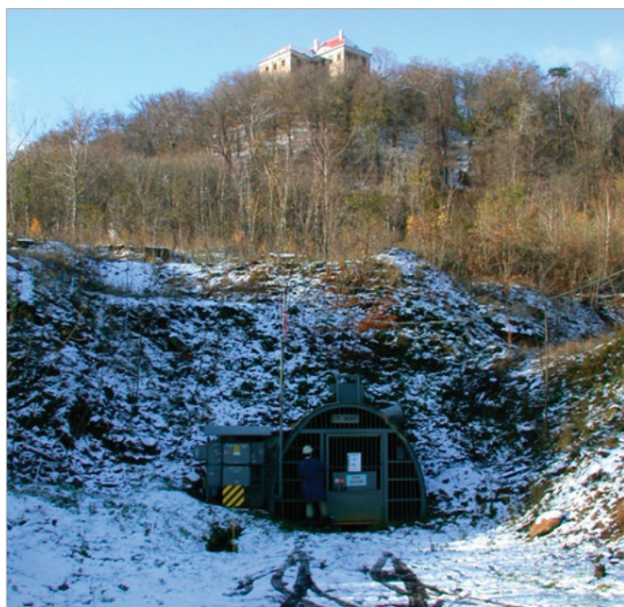
Obr. 4: Pohled na vstupní portál štolý Jezeří se zámek Jezeří v pozadí na svahu Krušných hor. V současnosti se vlevo od vchodu nachází objekt Monitoringu.
