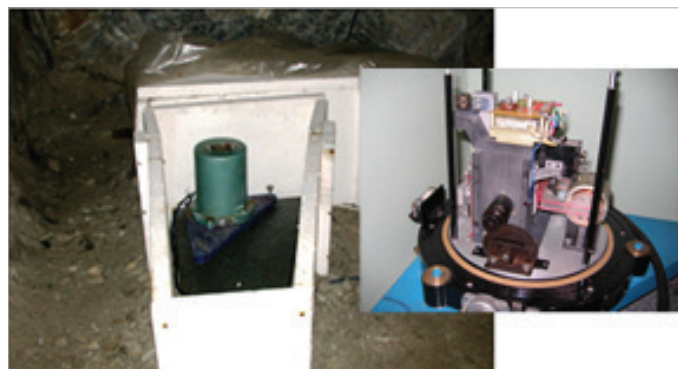
Obr. 5: Náklonoměr je instalován ve štolě na stabilní kamenné desce a obklopen tepelnou izolací s cílem potlačit rušivé vlivy na měřená data. Vpravo je zobrazena vnitřní konstrukce náklonoměru.
