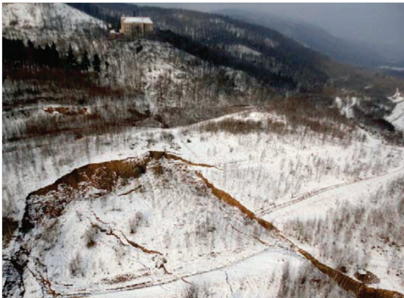
Obr. 9. Sesuv v severozápadním svahu lomu ČSA z roku 2011. V pozadí na svahu zámek Jezeří.
