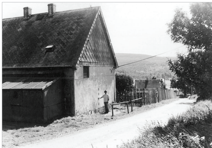
Obr. 2: Ukázka nivelačního bodu u domu z pořadu Z2b 11 v ploché, vrcholové oblasti Krušných hor, která je nejstabilnější (Foto: V. Vilímek).
