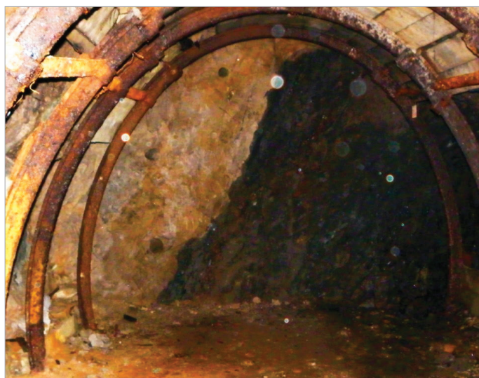
Obr. 5: Sedimenty Mostecké pánve strmě vyvlečené přes úpatí Krušných hor zachycené první rozrážkou štoly Jezeří. Sedimenty jsou lokálně uloženy i pod úhlem větším než 45^\circ , což zde dokládá rozštěpená uhelná sloj v písčitém vývoji miocénu. (Foto: J. Burda).
