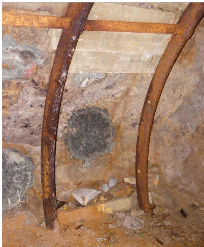
Obr. 6: Tvarové segmenty pro zatěžovací desku jako pozůstatky polní rozpěrné zkoušky v první rozrážce štolý Jezeří (Foto: J. Burda).
