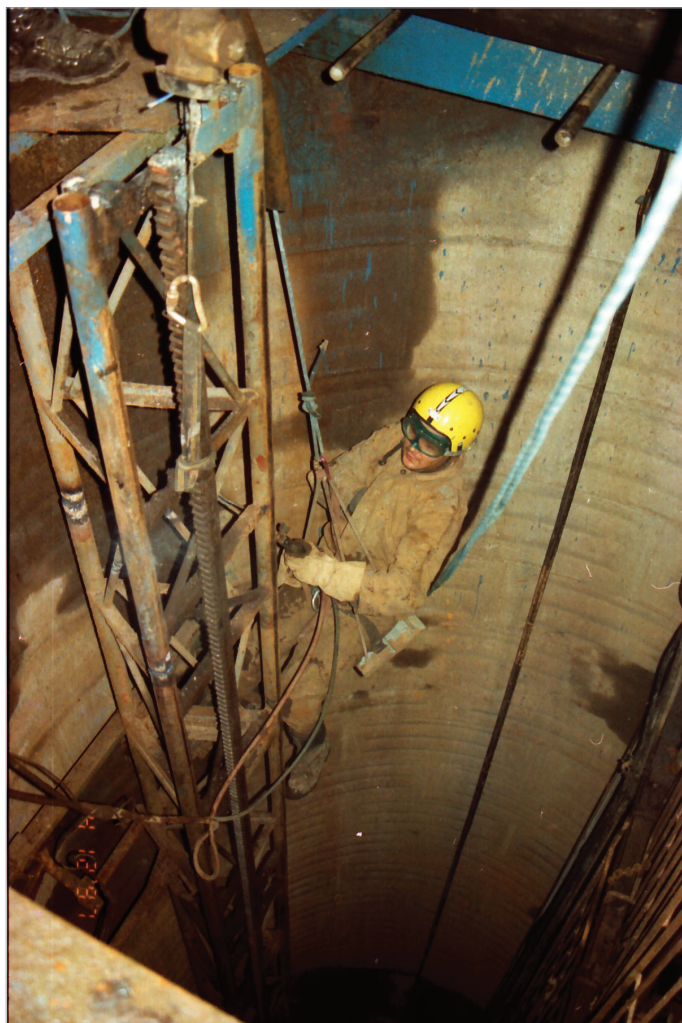
Obr. 3: Likvidace jámy – plenění dopravního zařízení v jámě (Foto: HBZS Most, 1997).
