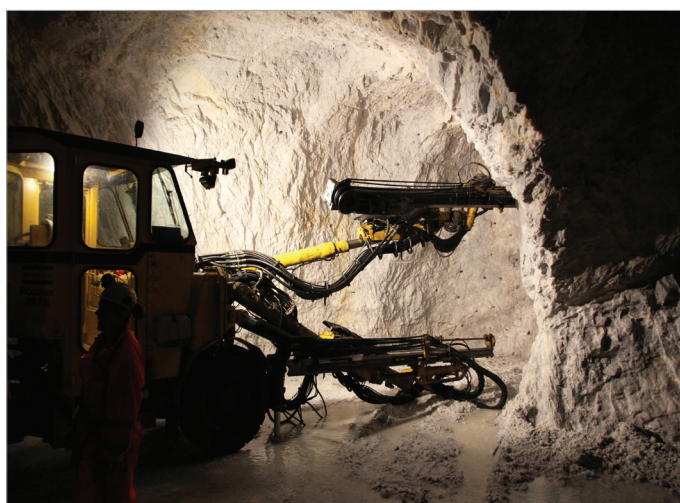
Obr. 23: Sondalo - vrtné práce.
