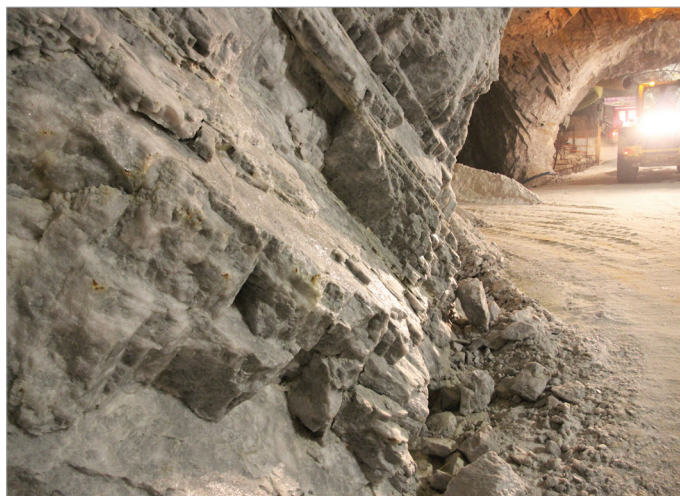
Obr. 25: Sondalo - detail masivní křemenné stěny.
