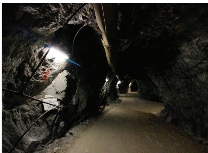
Obr. 22: Sondalo - úpadnice na úrovni 1 457 m n. m.
