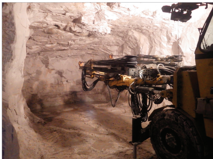
Obr. 6: Lochaline - postup vrtacích prací v těžební komoře.
