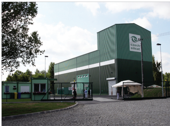
Obr. 15: Výrobní hala Czech Silicat v Horním Slavkově.
