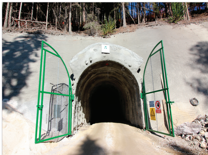
Obr. 20: Nová dopravní štola na úrovni 1 490 m n. m.
