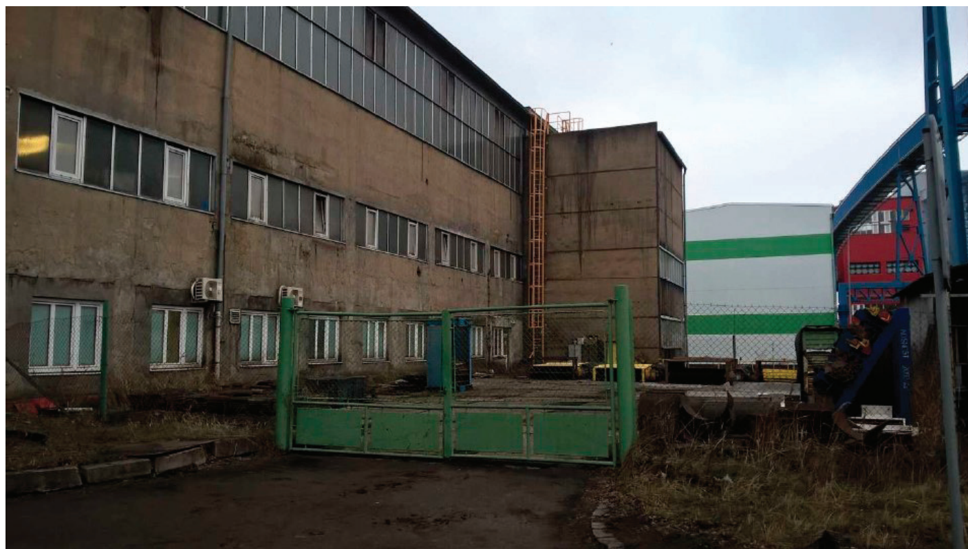
Obr. 2: Původní situace před instalací ocelové konstrukce pro filtrační jednotky.
