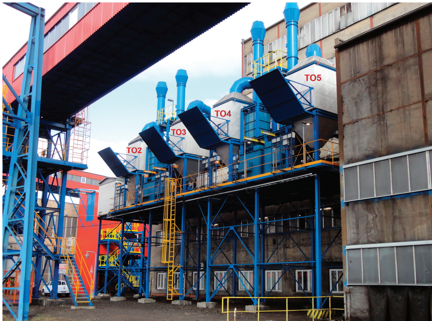
Obr. 5: Ocelová konstrukce s instalovanými jednotkami TO2 – TO5 po dokončení II. etapy.
