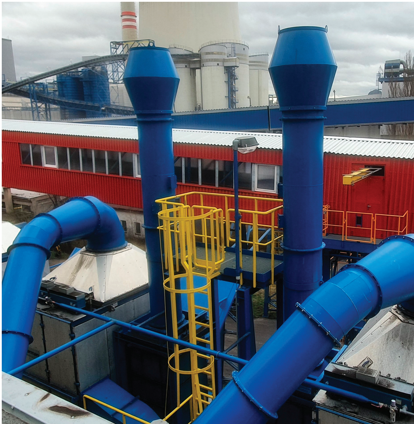
Obr. 3: Detail plošiny pro odběr vzorků TZL.
