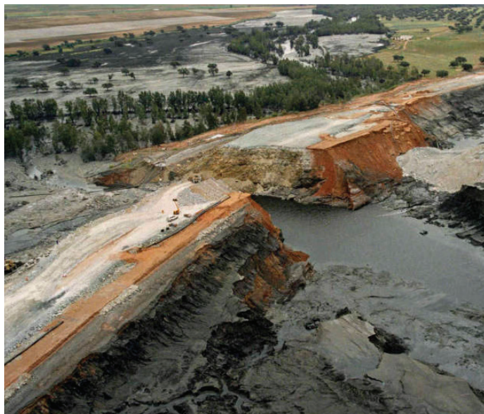
Obr. 3: Protržení hráze odkaliště zinkového dolu Aznalcóllar.
