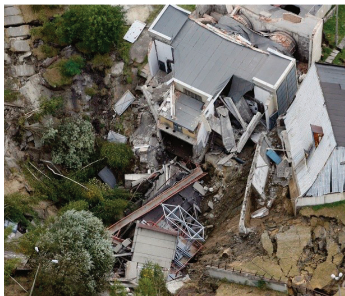
Obr. 2: Havárie těžní jámy s šachetní věží a přilehlými budovami v uhelném dole Szczygłowiec.
