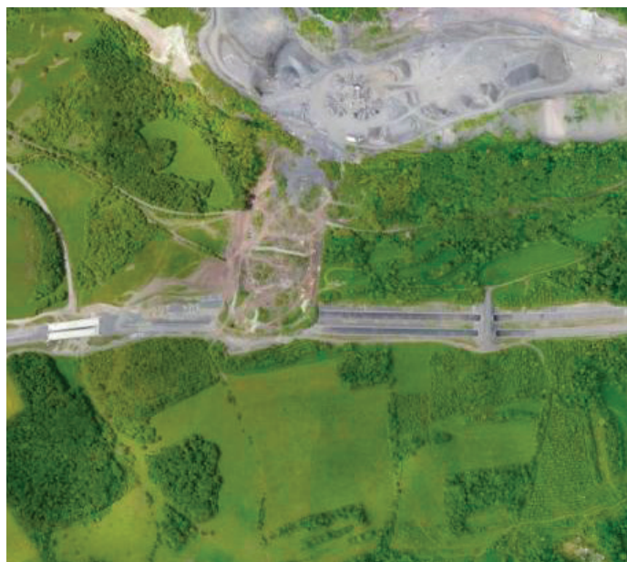
Obr. 6: Katastrofální sesuv v oblasti dálnice D8 pod lomem Dobkovičky.
