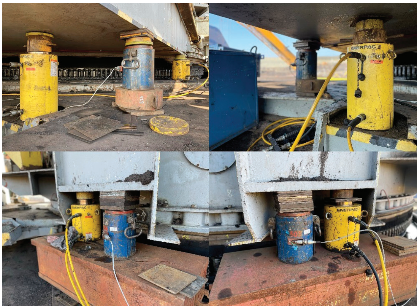
Obr. 9: Umístění hydraulických zvedáků a tlakových dynamometrů TLD na spodní stavbě velkstroje KU 300.
