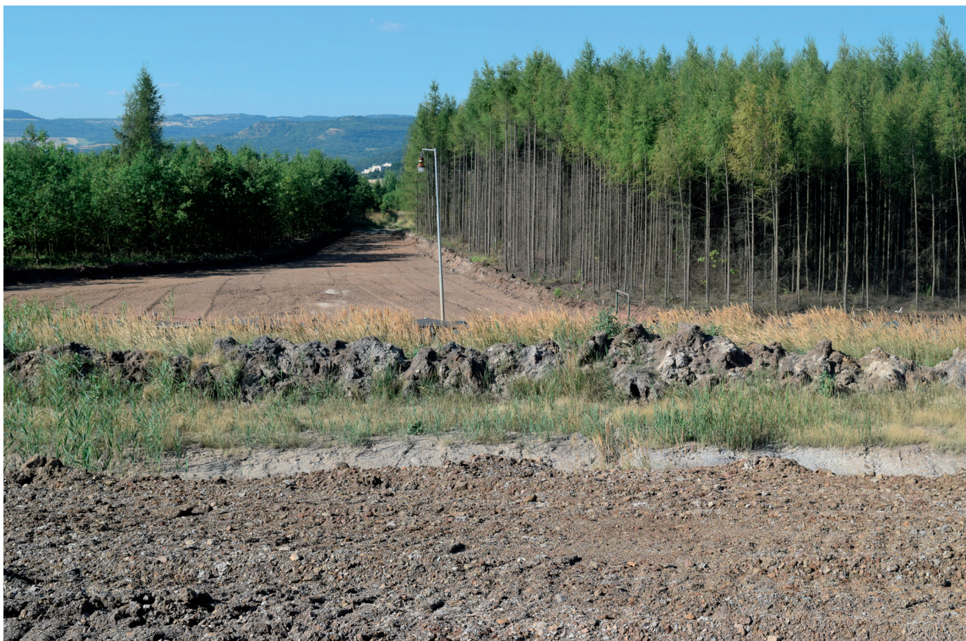
Obr 5: Zájmová plocha Prunéřov VI po odstranění svrchního horizontu (horní část snímku). (Foto: M. Řehoř)
